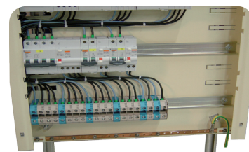
Bas de châssis ouvert pour départs câbles candélabres
