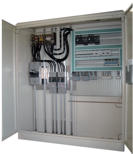
Armoire de distribution générale et de commande
